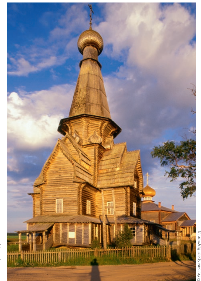
▼ Успенская церковь (1674) в селе Варзуга Терского района Мурманской области. Как и многие храмы Русского Севера, сооружена «без единого гвоздя»
